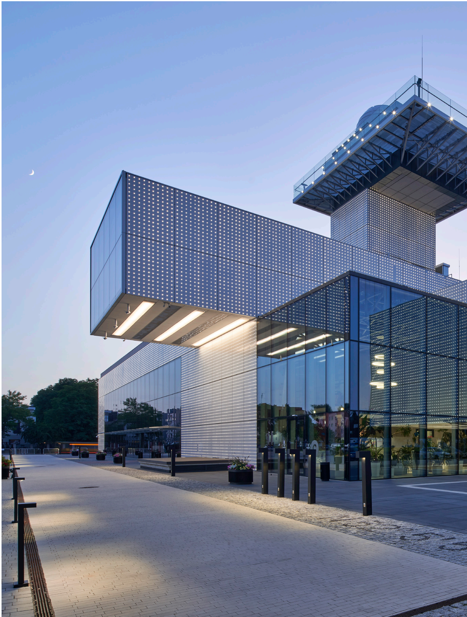
The CAiIS Performance and Sports Hall, Grodzisk Mazowiecki, Poland, project: Paweł Tępiłow - Pracownia Projektowa, photo: Bartosz Makowski Hala Widowiskowo- Sportowa CAiIS, Grodzisk Mazowiecki, Polska, projekt: Paweł Tępiłow - Pracownia Projektowa, fot. Bartosz Makowski
