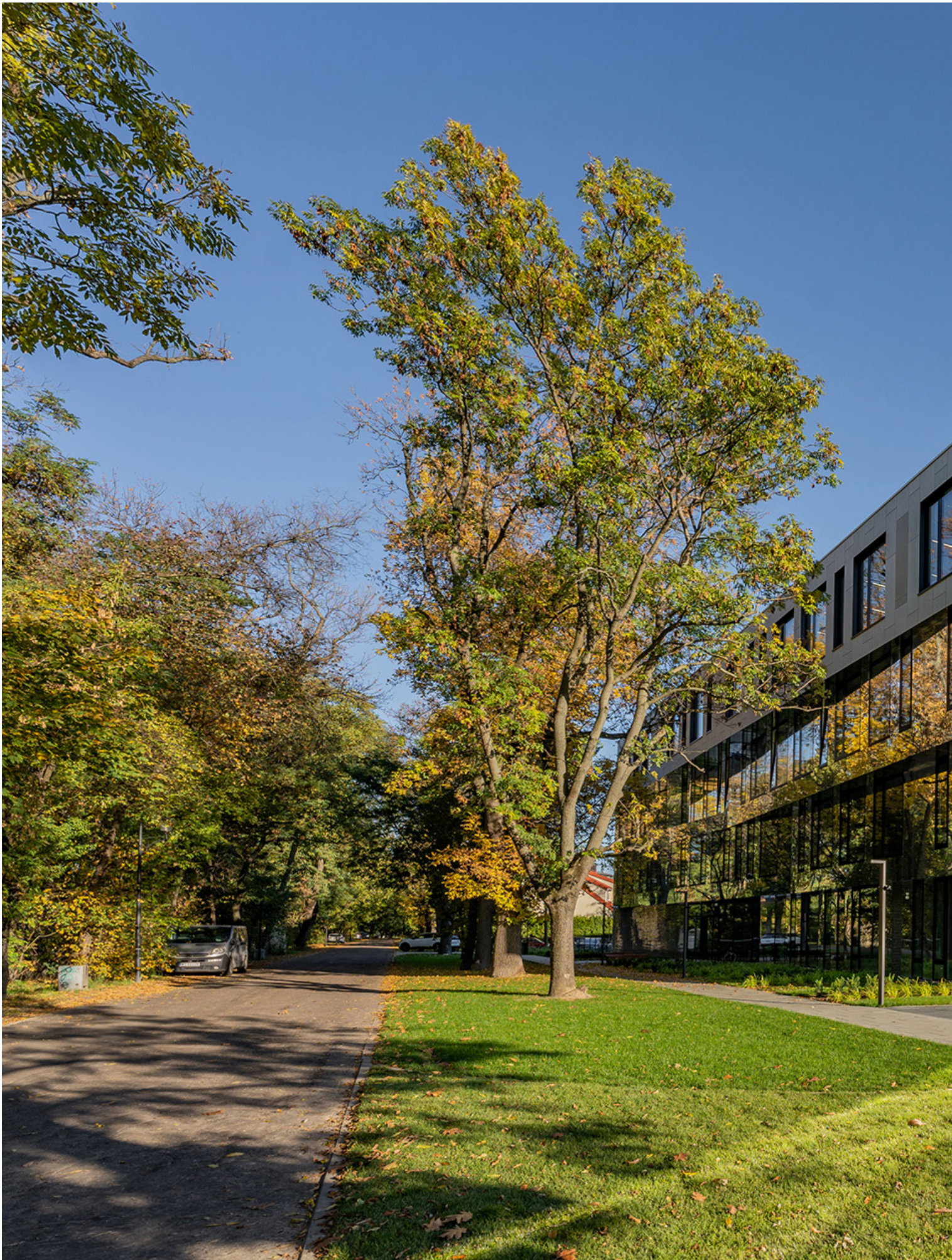
Office Building Poleczki 32, Warszawa, Poland, project: A5 Architekci Budynek Biurowy Poleczki 32, Warszawa, Polska, projekt: A5 Architekci
