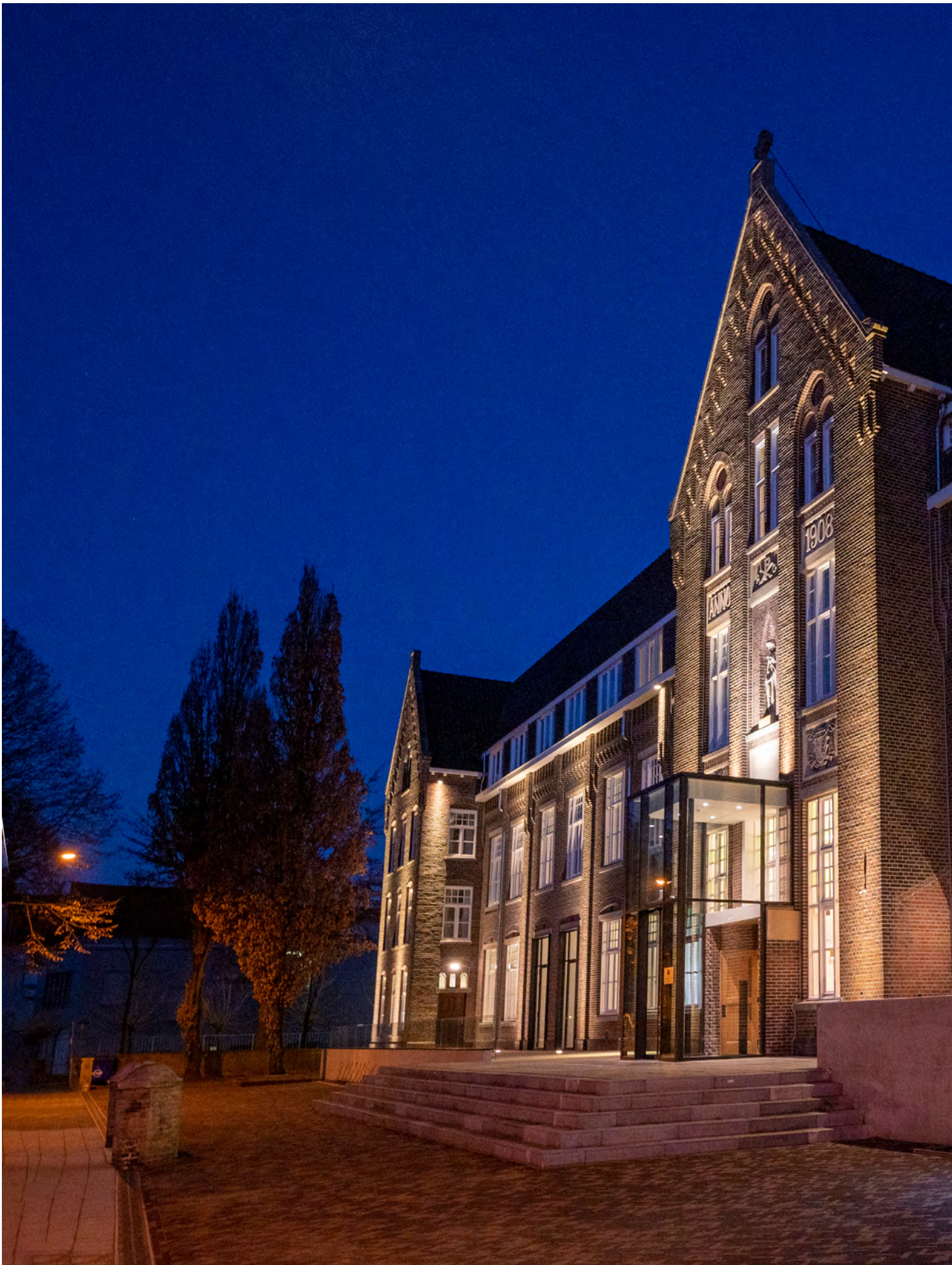
Hotel DoubleTree by Hilton Sittard Nederlands, project: Lueur B.V. Maastricht, HOMIJ Technische Installaties Ittervoort, photo: Anton Daal fotografie Hotel DoubleTree by Hilton, Sittard, Holandia, projekt: Lueur B.V. Maastricht, HOMIJ Ittervoort Instalacje techniczne, fot. Anton Daal fotografie
