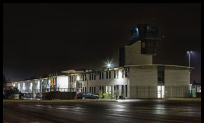
Vorplatzbeleuchtung am Flughafen Mannheim
